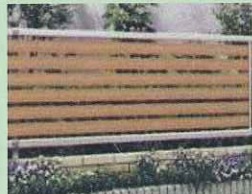
フェンス設置
