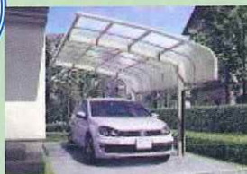
カーポート設置
